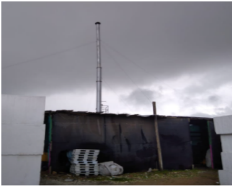
Fotografía 9: Adecuación de altura de chimenea de 11.32 a 16.95 m 25/06/2021
