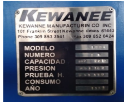
Fotografía 8: Placa caldera de 60 BHP
