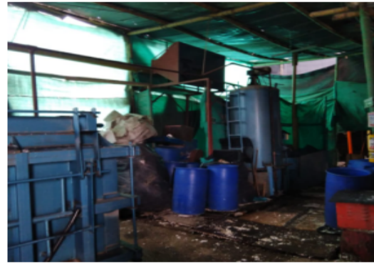
Fotografía 10: Adecuación de sistema cerrado de extracción a procesos de Expansión y Pre – expansión 25/06/2021
